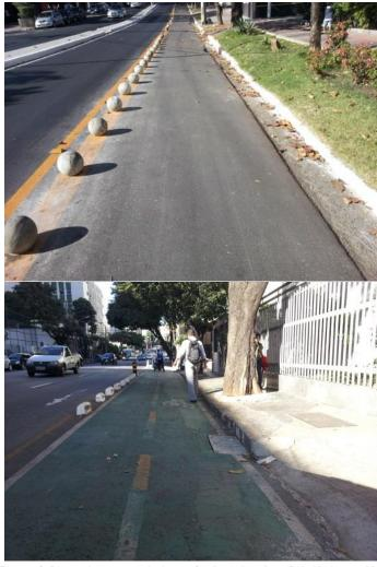
Figura 76: Blocos de concreto do tipo "esfera" e "prisma" em Belo Horizonte, MG Fonte: Tectran / Idom, 2013.
