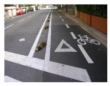
Figura 84: Dispositivo de borracha em Barcelona, Espanha Fonte: Tectran / Idom, 2013.
