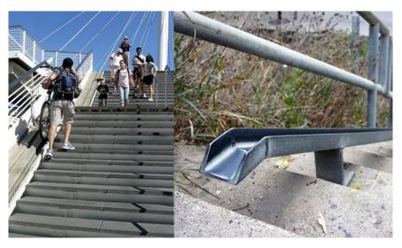
Figura 119: Canaleta inclinada para transporte de bicicletas em escadas Fonte: *Blog Rider*, s.d.
