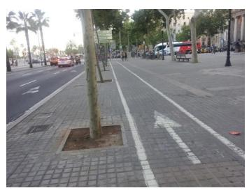
Figura 88: Sinalização Horizontal indicando o sentido de ciclovia em Barcelona/Espanha Fonte: Tectran / Idom, 2013.
