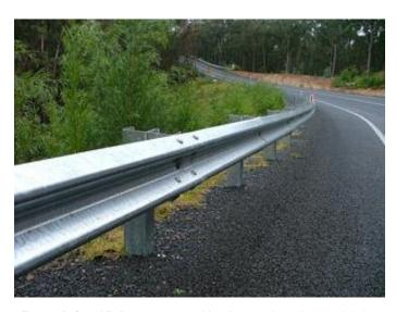
Figura 74: Guard Rail – proteção considerada não-adequada para ciclovias Fonte: Portal MadeinChina.com, s.d.
