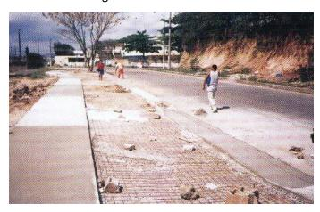
Figura 78: Reforço da base do pavimento em área de cruzamento de veículos sobre a Ciclovia em Campo Grande, RJ
