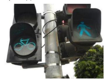
Figura 93: Semáforo para ciclistas junto ao semáforo de pedestres em Curitiba, PR Fonte: Gazeta do Povo, 2013.
